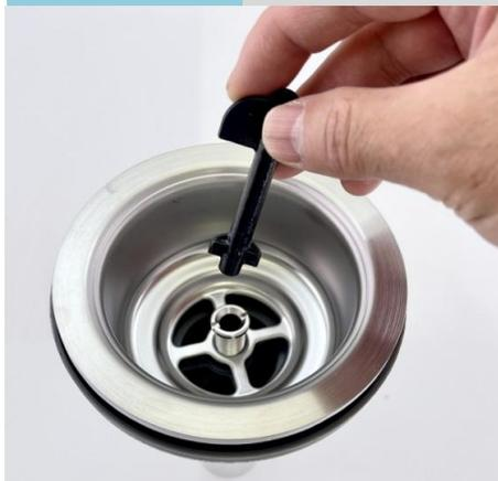
Step.2 の図のように、④⑤と⑥⑦を排水穴に取り付け、③センターボルトを④と⑦の中央の穴に通します。
